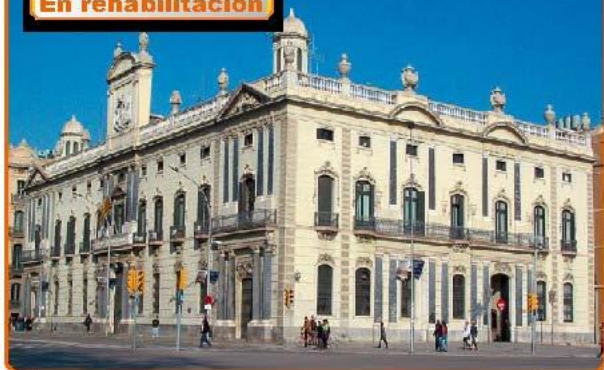
EDIFICIO DE LA DELEGACION DEL GOBIERNO EN CATALUÑA
